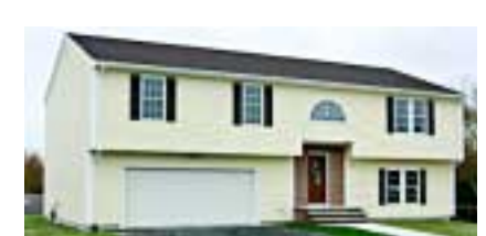
Casas novas em construção
